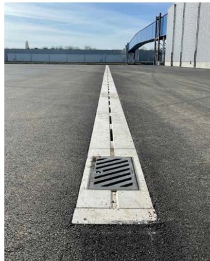
Industriële lijnafwatering: speciaal ontwikkeld voor gebieden waar sprake is van zeer zwaar verkeer, zoals containerterminals, luchthavens, logistieke terreinen of industrieterreinen.
